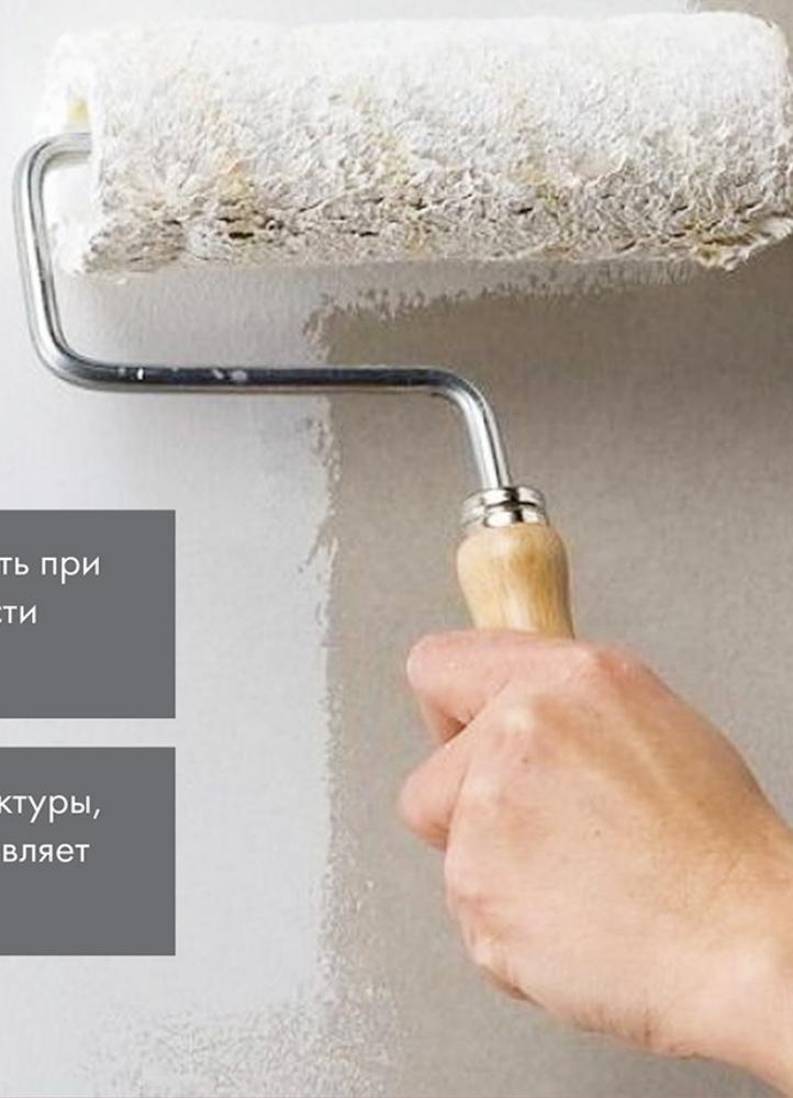
**Температура нанесения:** работы следует производить при температуре не ниже +5 °С и относительной влажности воздуха не более 80 %
